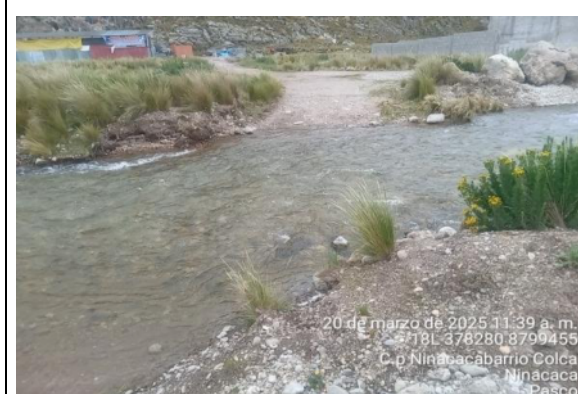
Fotografía 3: Quebrada Seca, cauce colmatado y erosion de riberas ambas margenes, punto de desborde.
