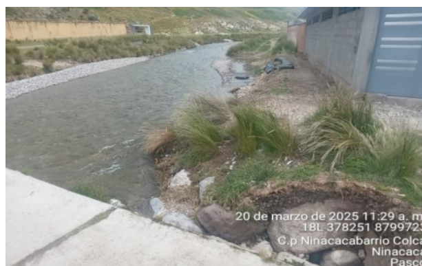
Fotografía 2: Quebrada Seca, cauce colmatado y erosion de riberas ambas margenes
